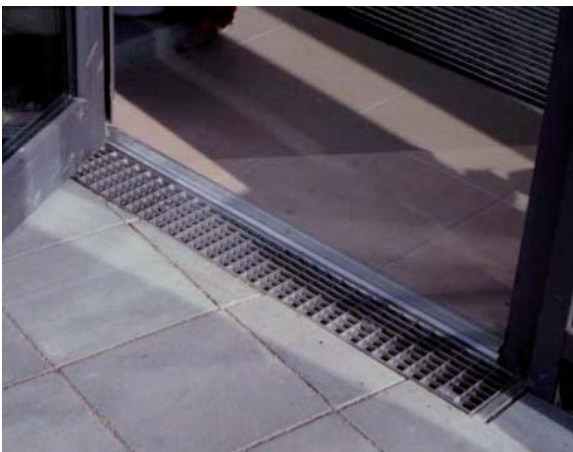
Bild 4 Schwellenfreier Zugang mit Wassersammelrinne und Gitterrost
