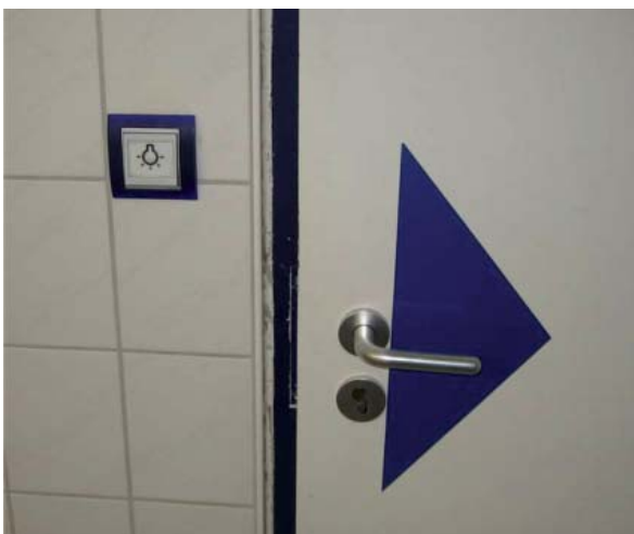
Bild 8 Kennzeichnung von Türdrückern durch einen kontrastreichen Aufkleber
